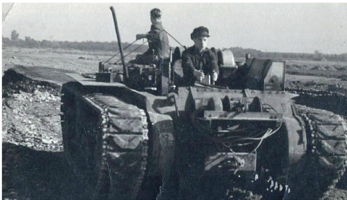
AANLEG VLEGVELD BEEK
